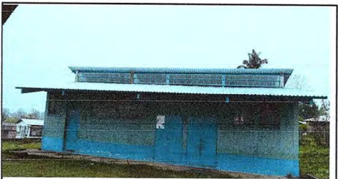
Foto 4: Mantenimiento de estructuras metálicas y entechado del módulo II finalizado.
