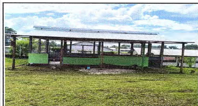
Foto 3: Gracias al Ministerio de Educación con el Programa de Remozamiento se logró comprar láminas para el entechado de la cocina del establecimiento educativo
