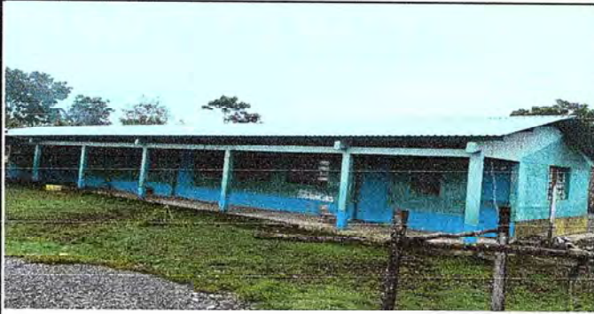
Foto1: Cubierta de lámina, módulo I finalizado.
