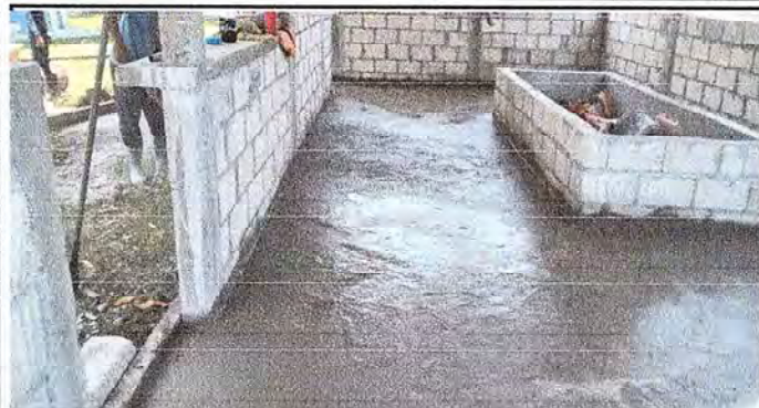
Foto1: Gracias al Programa de Remozamiento se logró comprar cemento para el piso de la cocina del establecimiento educativo.
