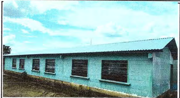
Foto 2: Entechado del módulo I totalmente finalizado.
