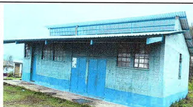
Foto 5: Colocación de vidrios, módulo II finalizado.
