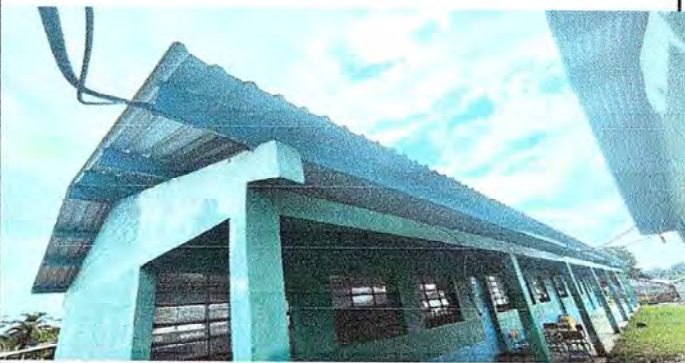
Foto 3: Mantenimiento de estructuras metálicas del módulo I finalizado.
