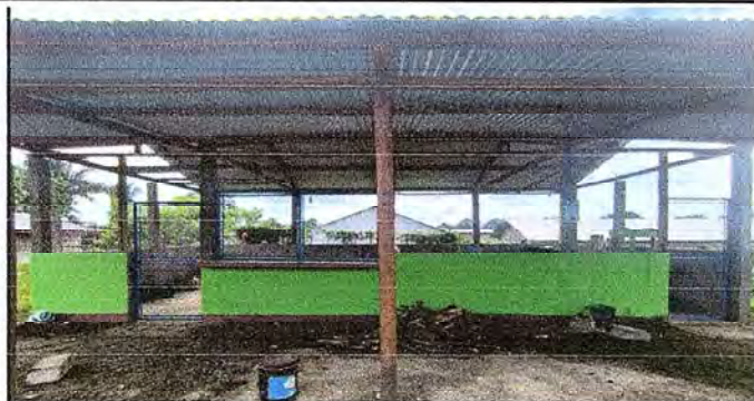
Foto 2: Se logró comprar e instalar las puertas, ventanas y malla de la cocina del establecimiento educativo.
